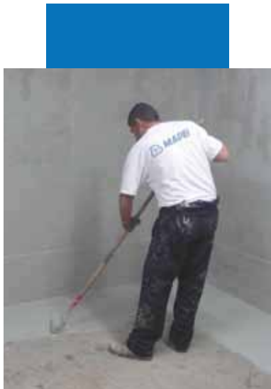
Нанесение Mapelastic Foundation валиком для гидроизоляции в условиях отрицательного давления воды
