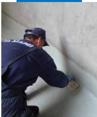
Нанесение Mapelastic Foundation шпателем для гидроизоляции в условиях положительного давления воды
