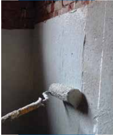
Нанесение Mapelastic Foundation валиком на основание, выровненное Planitop HDM Maxi
