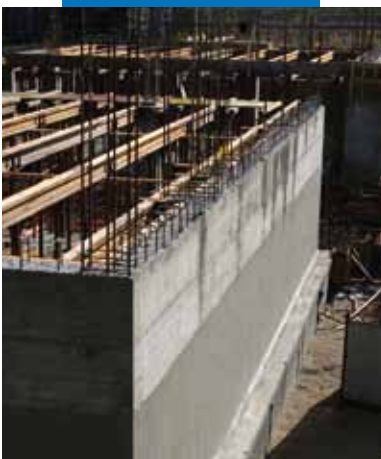
Гидроизоляция монолитного железобетонного фундамента используя Mapelastic Foundation
