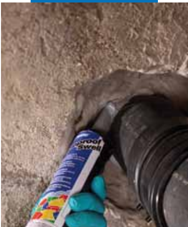
Проходной элемент, загерметизированный с помощью Maaproof Swell
